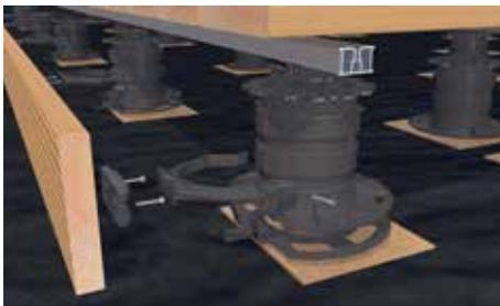
*Fixation d'un bandeau en bois à l'aide d'un support de bandeau.*
